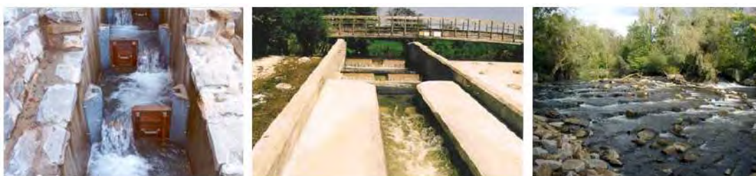
Figura 8 - Passaggio a bacini successivi, Passaggio di tipo "Denil", Passaggio a rapida artificiale (Provincia di Mantova, 2009).
